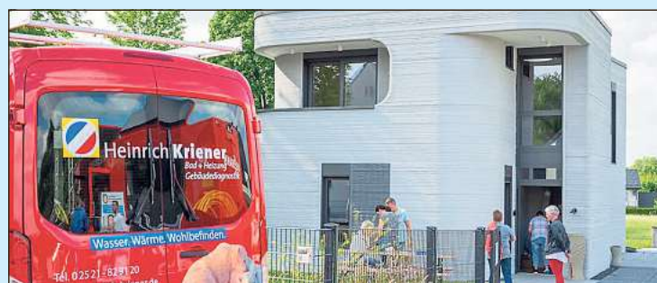
Beim Bau des 3D-Druckhauses am Sudhoferweg in Beckum brachte sich das Unternehmen ein und leistete Pionierarbeit.
